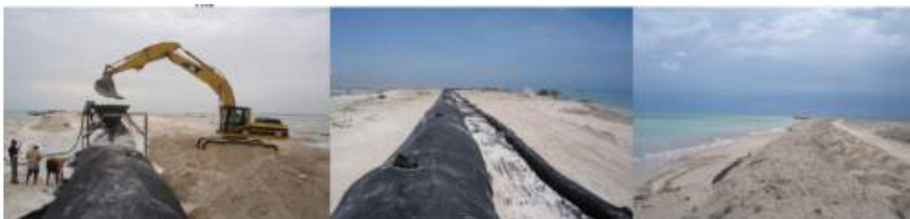
**Figura 12.** Construcción de una duna artificial con tubo geotextil en Las Coloradas, Yucatán.
