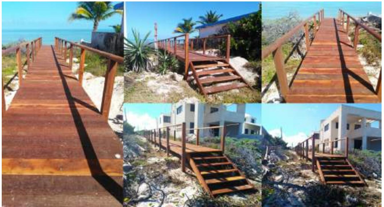
**Figura 18.** Pasarela de 25 m en proyecto de restauración Telchac-Chixchulub. Protege un área vegetada de 200 m<sup>2</sup>, con una elevación aproximada de 50 cm desde el nivel del suelo. Permite el libre acceso y tránsito peatonal en un área pública con salida a la playa. Fotografías: Gabriela Mendoza.
